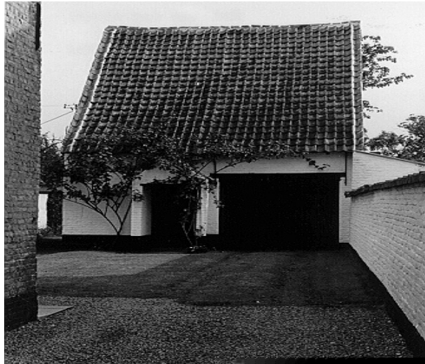
Atelier Van de Woestijne vóór de instorting (het oorspronkelijke was breder)
